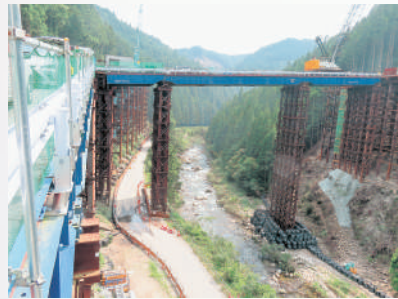
付け替え道路仮橋工事
